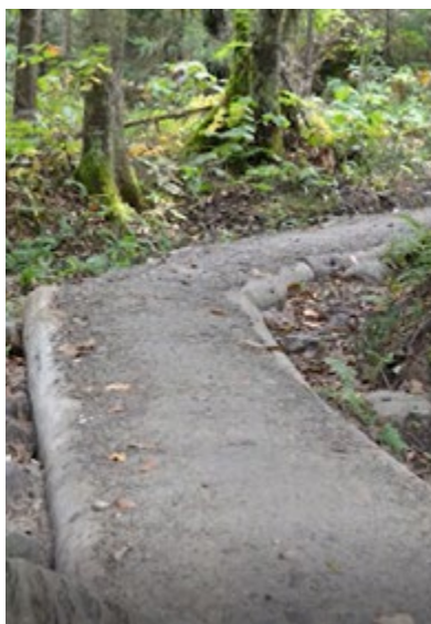
Sentier sur remblai en milieu plat
