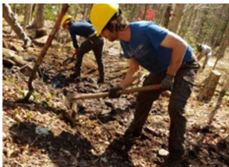
Retrait de la matière organique précédant l'excavation du sol minéral
