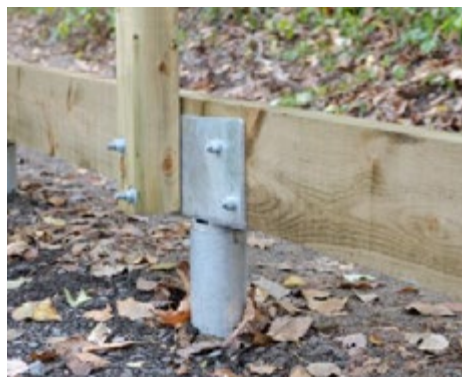
Ancrage sur pieux vissés
