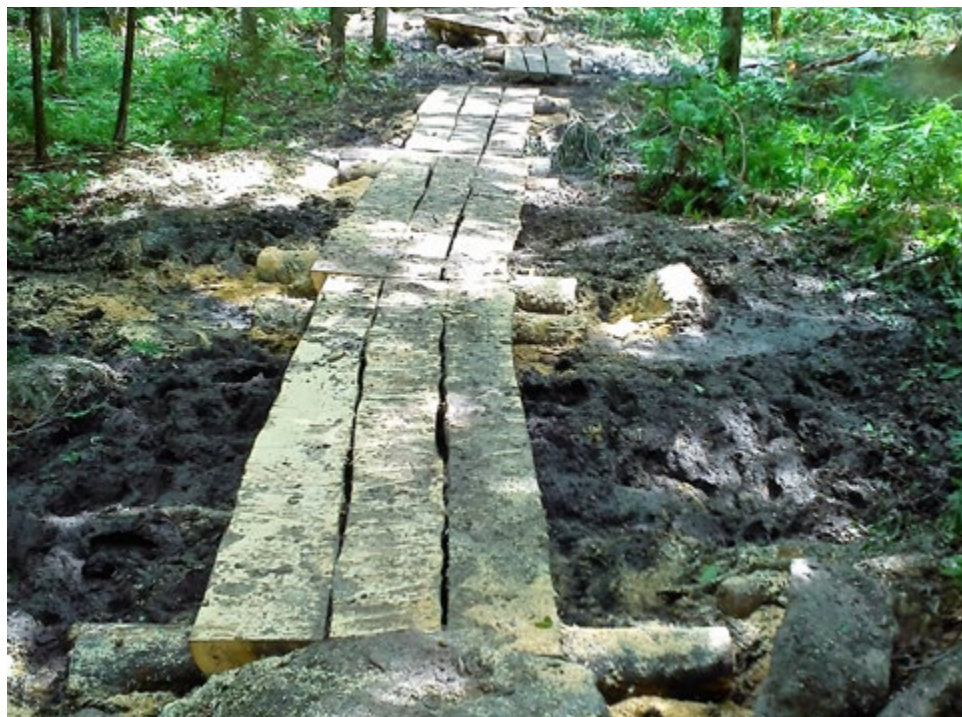
Trottoir de bois sur troncs délignés (split beam)
