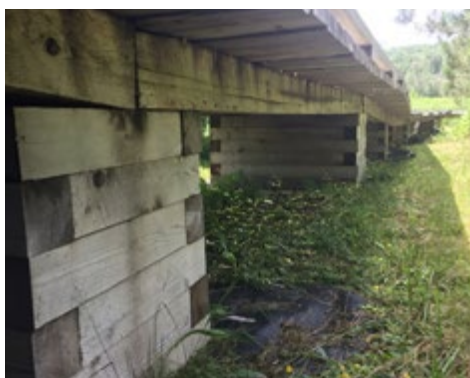
Appui sur assise en caisson ou radier
