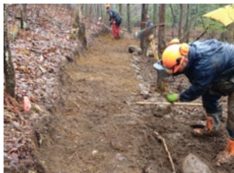
Sentier sur déblais
