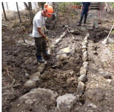
2. L'aire de marche comprise entre les parois de pierres ou de bois est empierrée et la surface compactée manuellement avec une tête de masse, un « McLoad » ou avec un « rogue hoe ». L'empierrement doit atteindre une épaisseur minimum de 15 cm (6 po) au-dessus du sol naturel.
