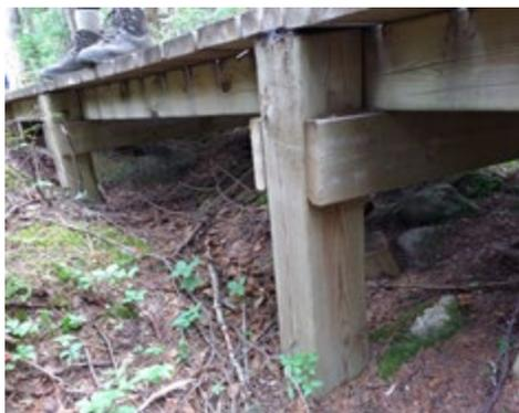
*Ancrage sur poteaux en appui sur le sol ou enterrés*
