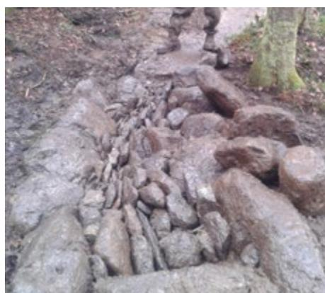
3. Il faut recouvrir la surface empierrée de 10 cm de sol minéral afin de la rendre confortable pour la marche, puis la compacter manuellement.
