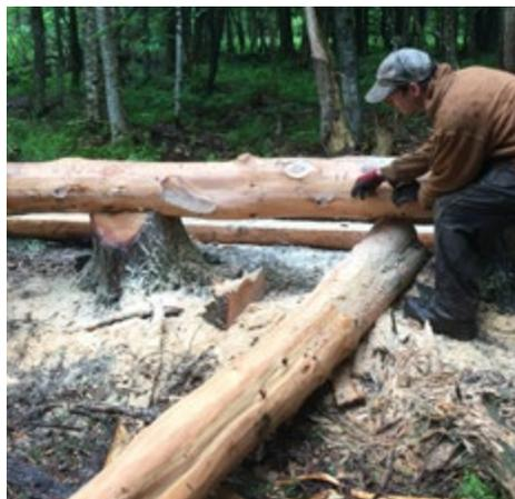
3. Les entailles servant à stabiliser le tablier du trottoir sur ses assises se confectionnent à même les troncs délinés. Cette technique empêche l'accumulation d'eau qui se produirait si on faisait l'entaille sur les billots servant d'assise.
